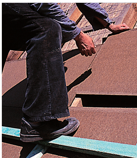
Schéma ci-dessus: pose des panneaux Celit 4D.
