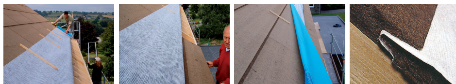
Photos ci-dessous: placement du lé de sous-toiture dans la rainure; placement de la bande Celit inférieure dans la rainure; placement du lé de sous-toiture sur le Celit; résultat: lé de sous couverture coincé dans le profil de la rainure.
