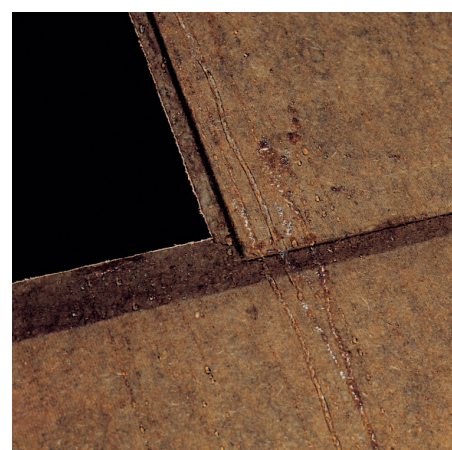
Photo ci-dessus: Emboîtement languette et rainure étanche au vent et à la pluie.
